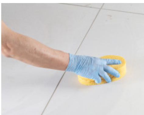
Reinigen en afwerken van voegen met een harde cellulose spons
